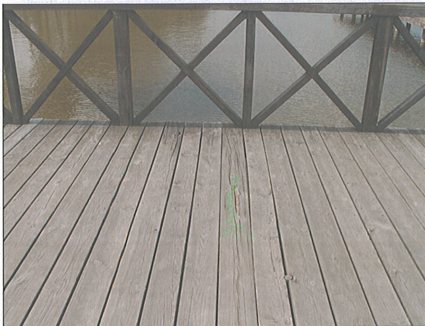
Fot. 3. Korozja biologiczna desek pokładu pomostu.
