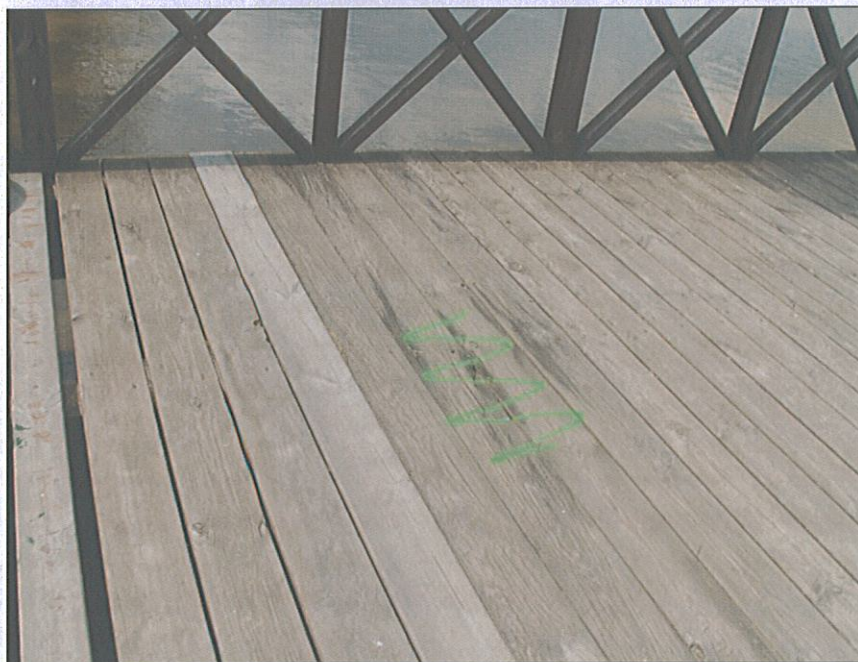
Fot. 4. Korozja biologiczna desek i podłużnic pomostu.
