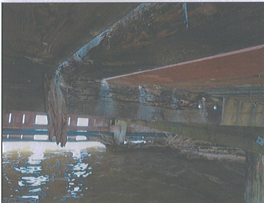
Fot. 8. Spróchniała podłużnica pomostu.
