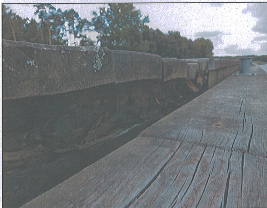
Fot. 4. Spróchniała podłużnica pirsu.
