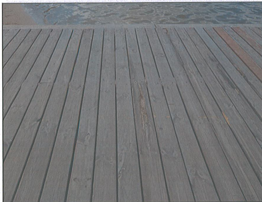
Fot. 3. Korozja biologiczna desek pokładu pomostu.
